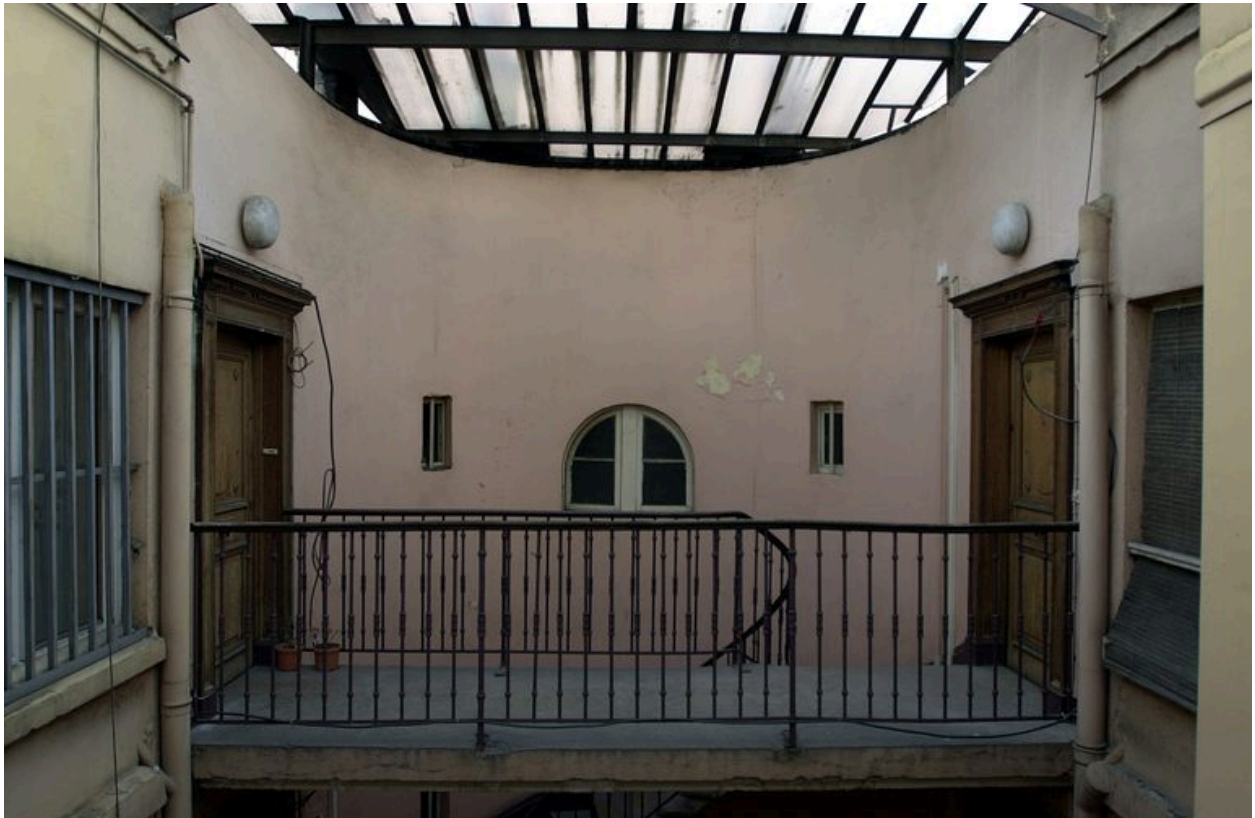
Escalier sud : palier du dernier étage
