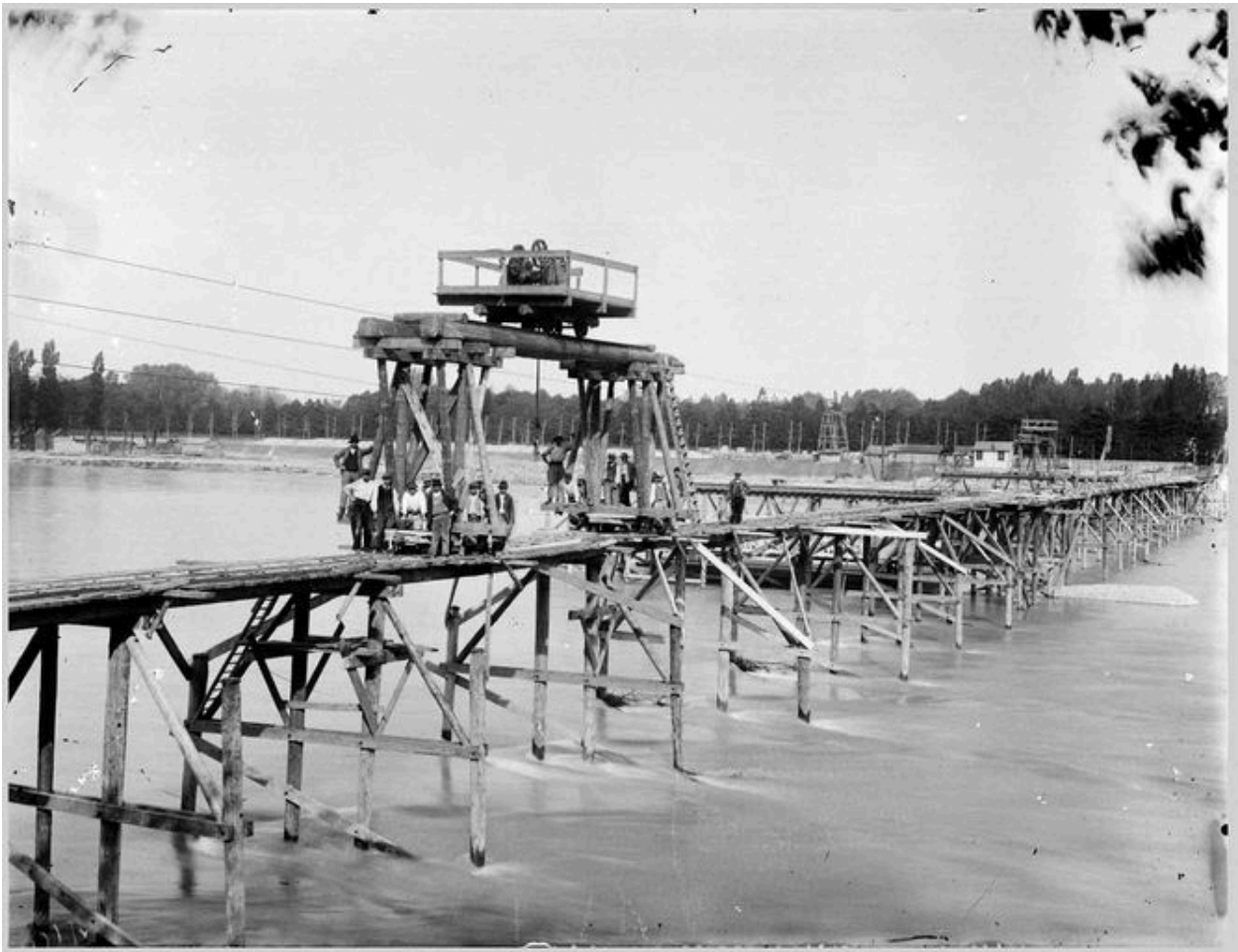
La construction du pont de la Boucle. La pose des maçonnerie des piles. [1902]. 1 photogr. : n. et b. (AM Lyon. 15 Ph 1800)
