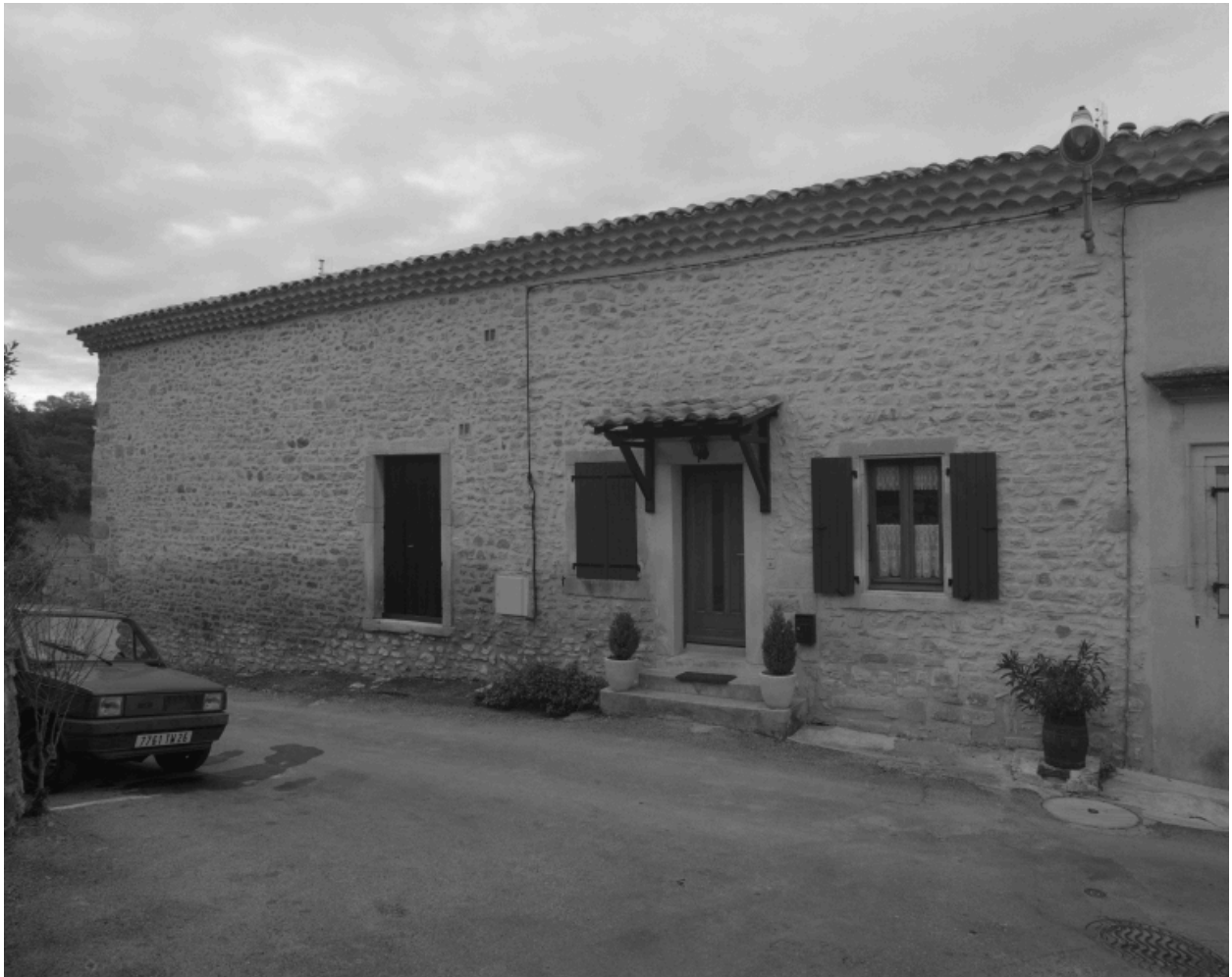
Le Pègue, Grand'rue. Maison (B3 676), élévation principale sur rue.
