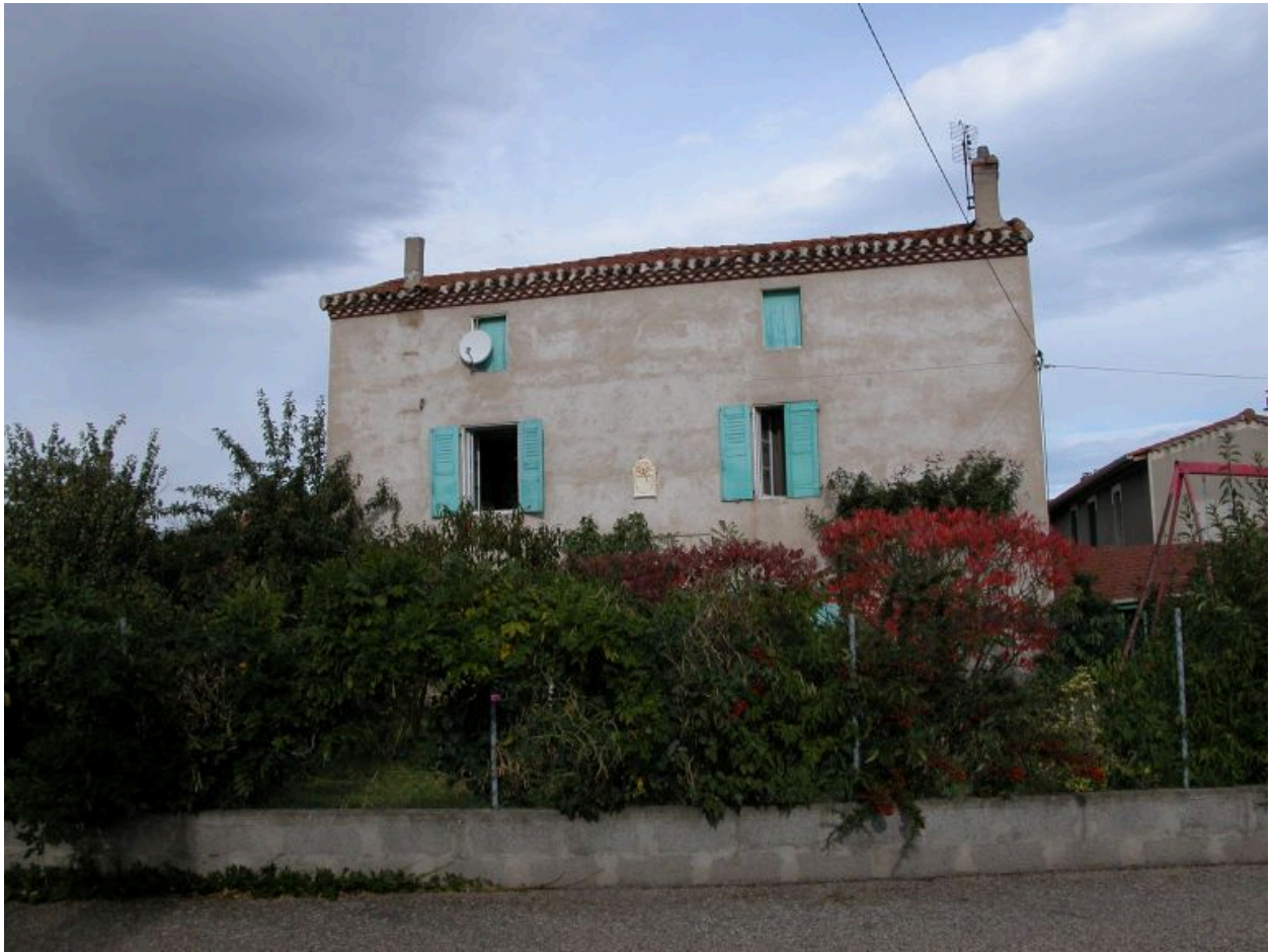
Vue d'ensemble de la façade arrière du logis.
