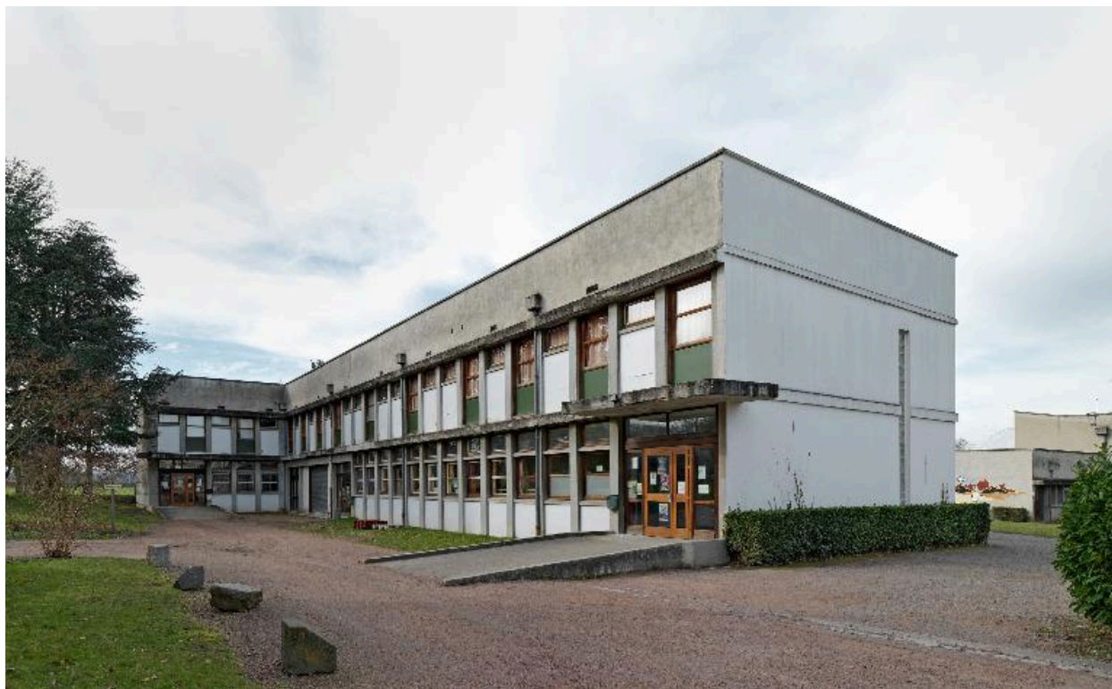
Bâtiment J : vue d'ensemble, depuis le nord-est
