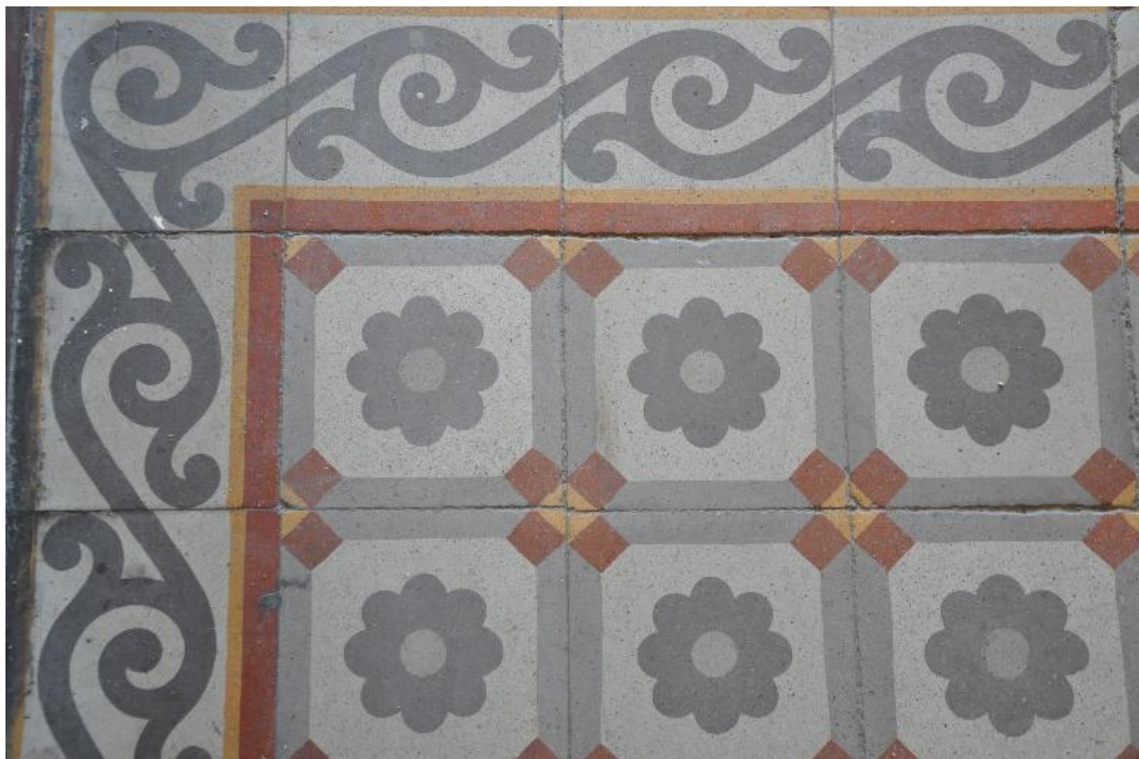
Sol en carreau de ciment
