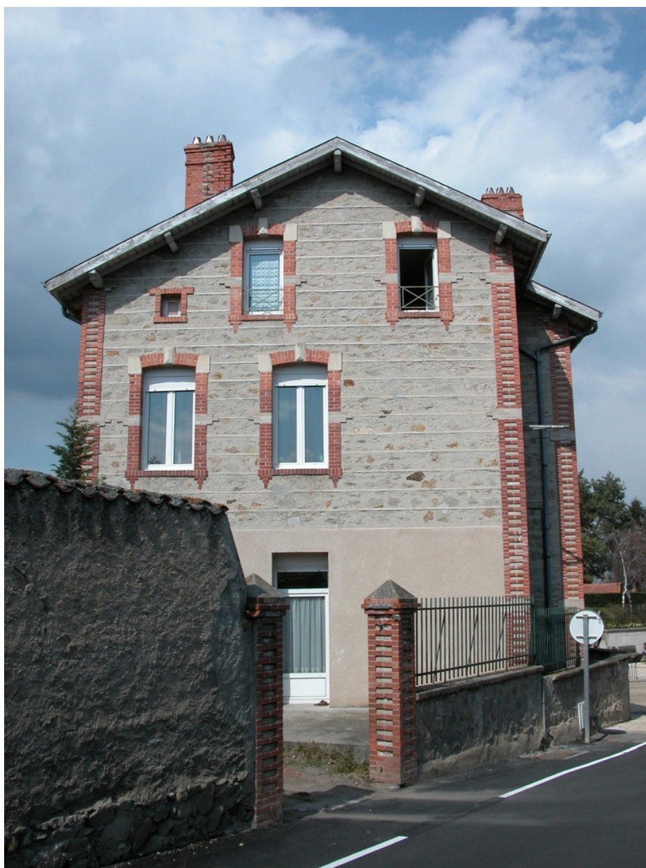
Maison, puis bureau de poste (puis maison) (1997 AZ 24). Vue côté rue de la Poste.
