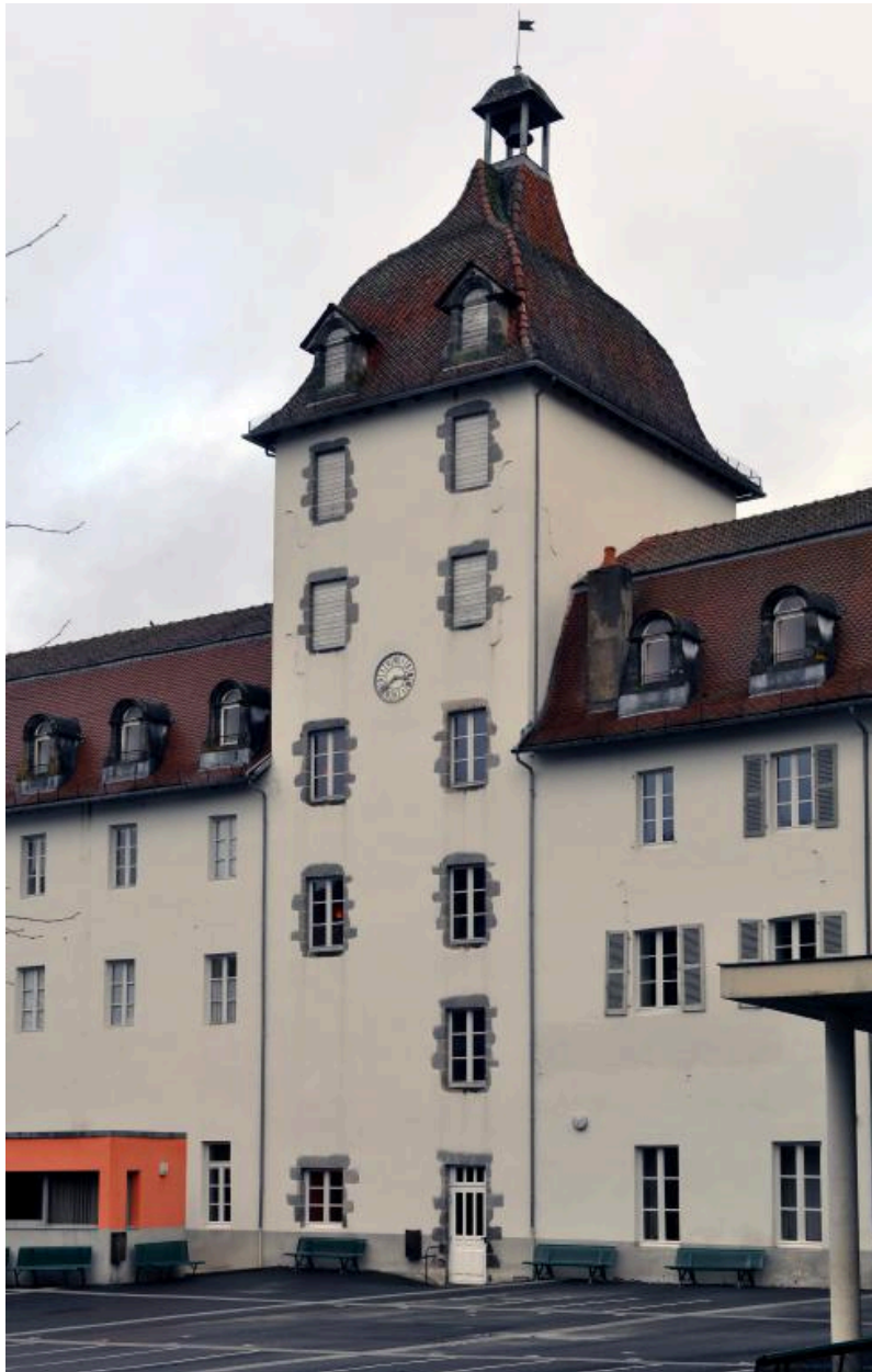
Bâtiment C : détail de la tour d'escalier
