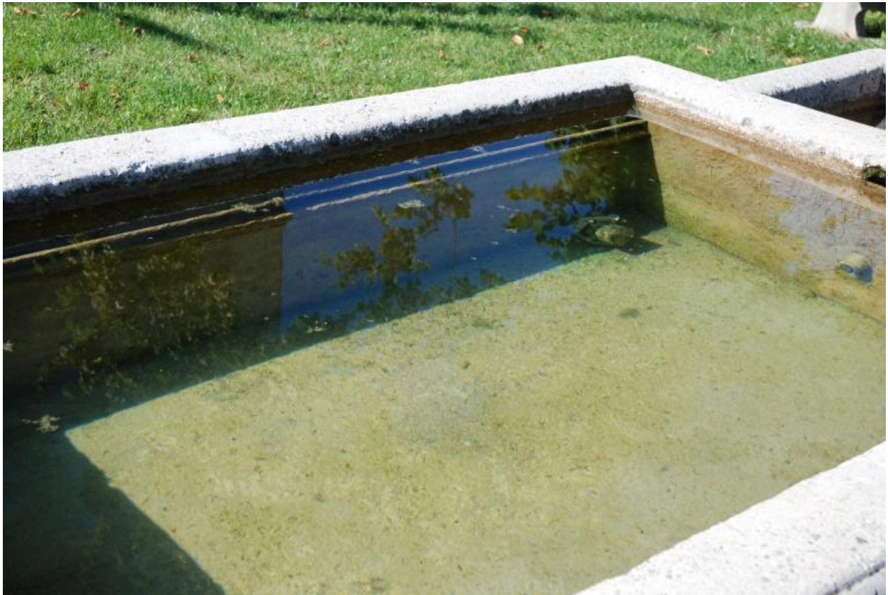
Vue du grand bac : détail des tringles.
