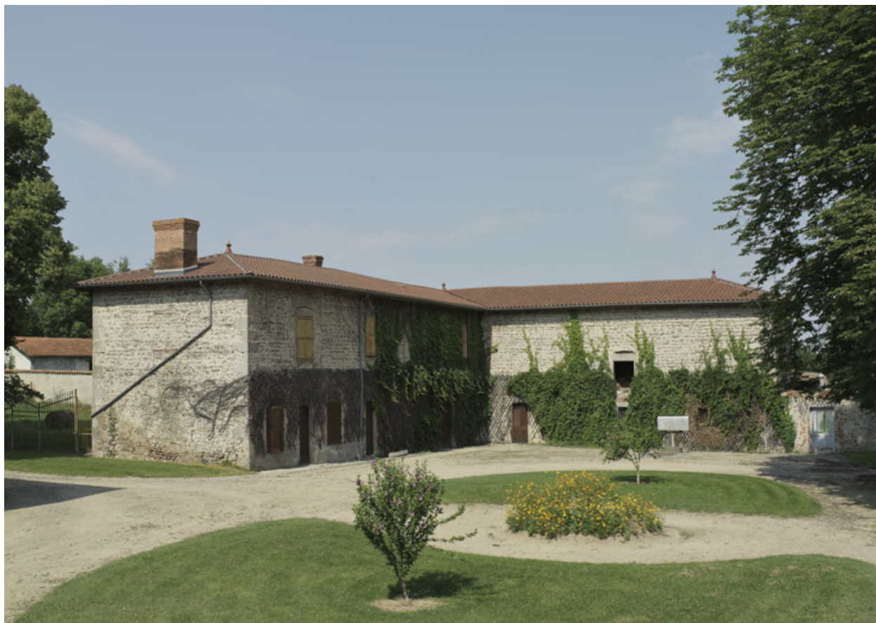
Vue d'ensemble du bâtiment de communs est, depuis la cour du château.
