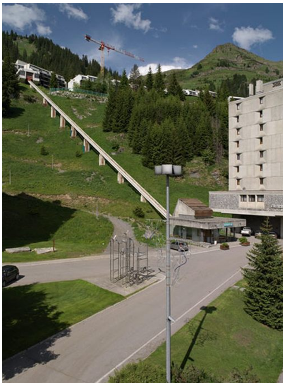
Vue générale depuis le sud-ouest
