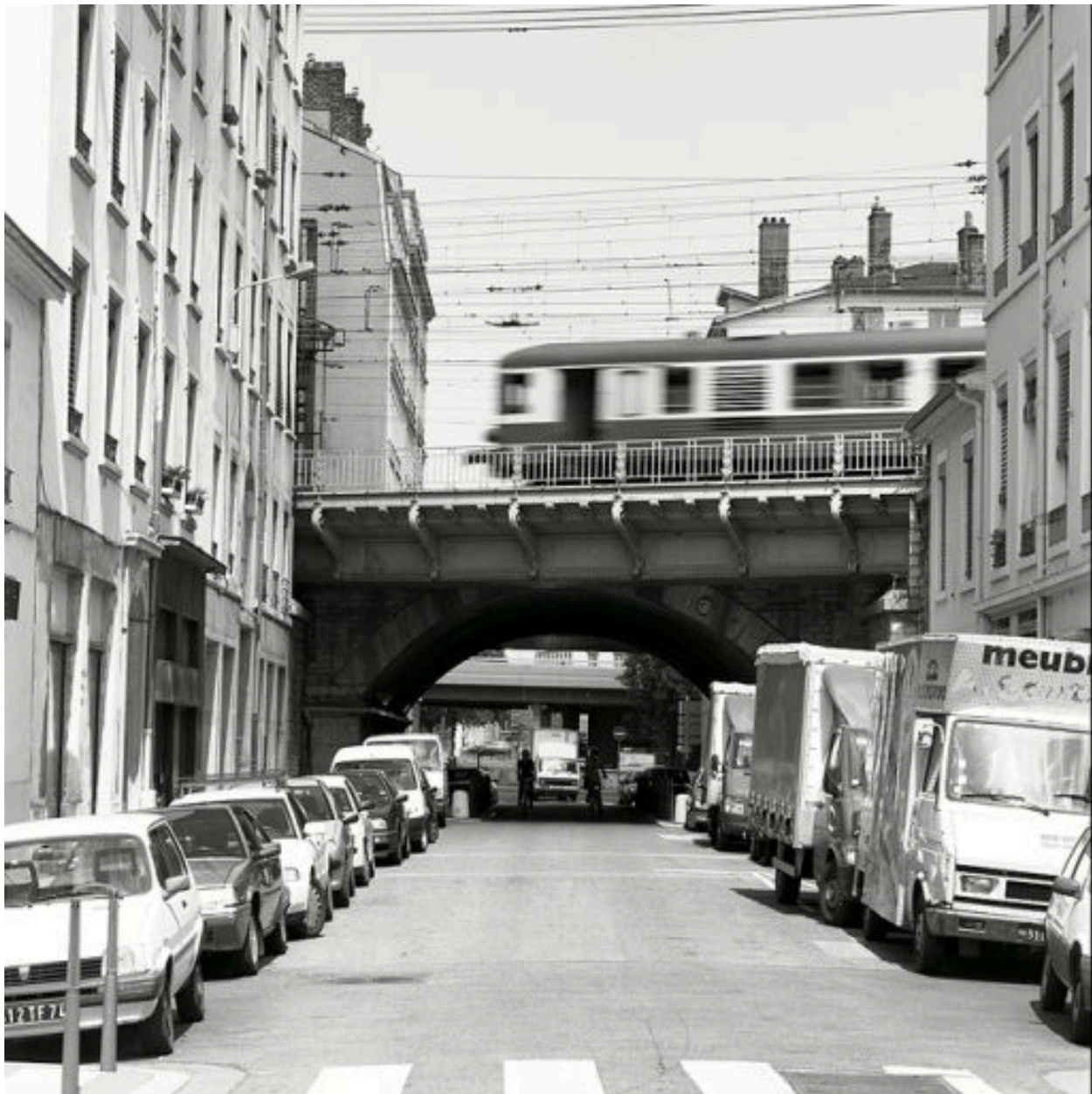
Vue générale depuis le nord
