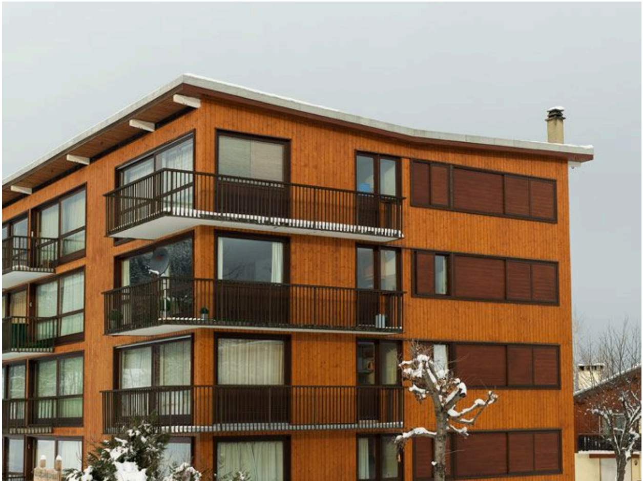
Détail du pignon est
