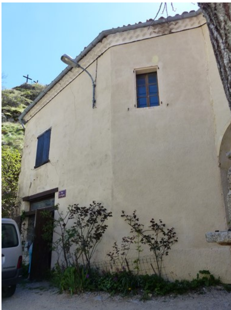
Maison-rempart, à l'entrée nord-est du village.
