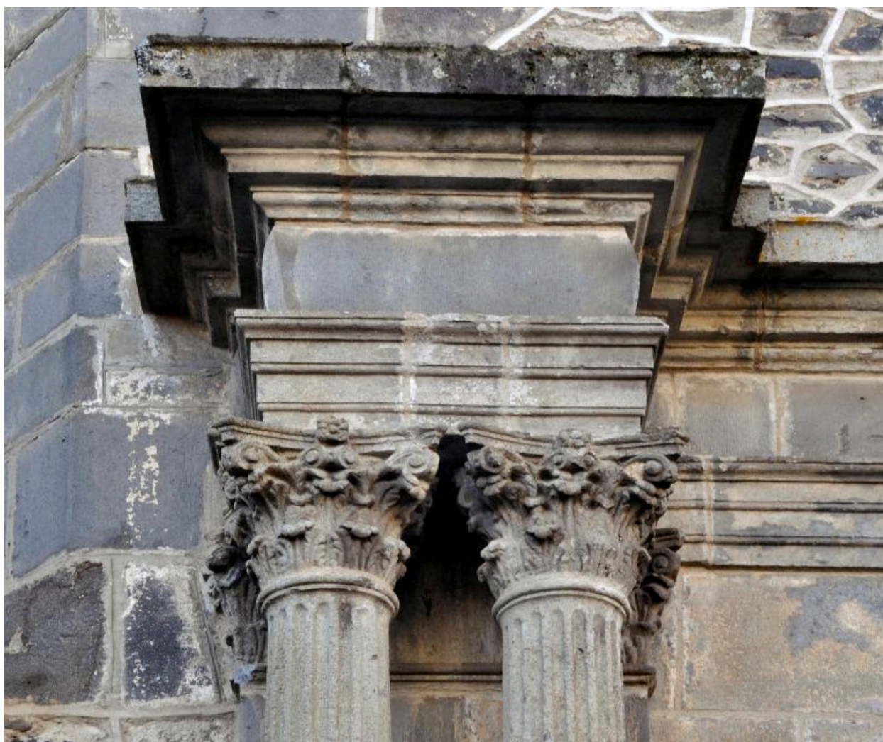
Portail : détail des chapiteaux
