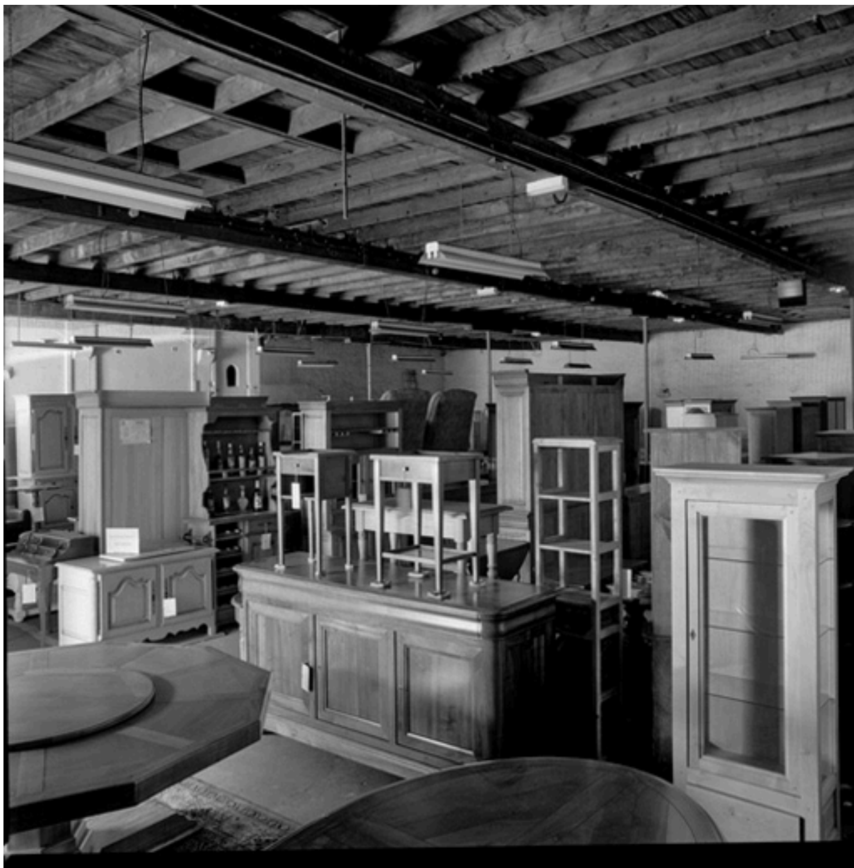
Charpente en bois de l'atelier
