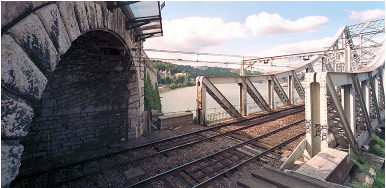
Le pont de la Mulatière et l'entrée du tunnel ferroviaire, rive droite de la Saône
