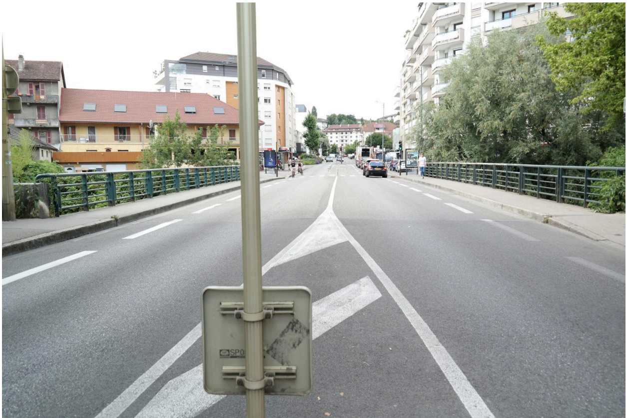
Pont Neuf, vue de la chaussée
