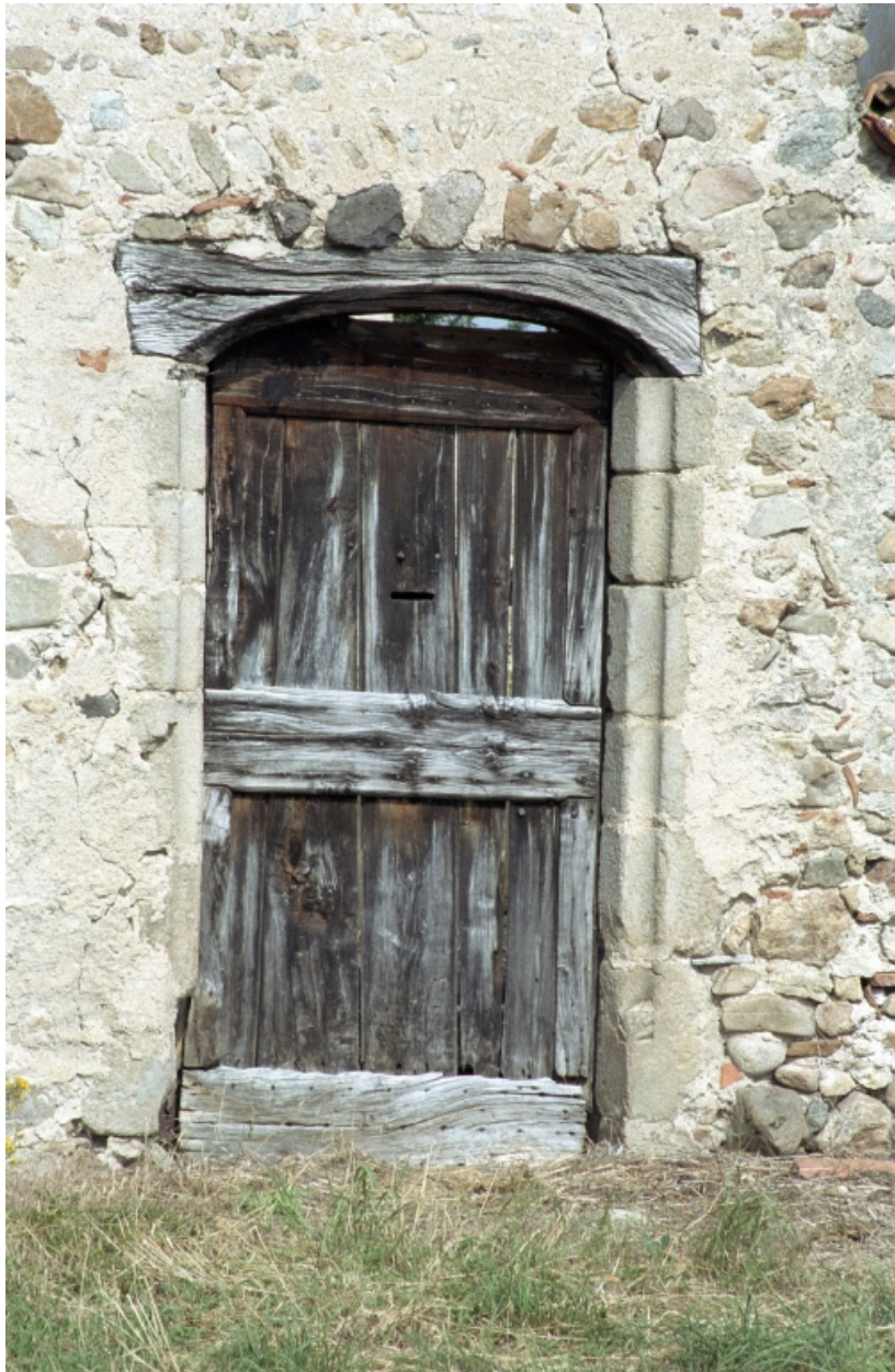
Montverdun, Meximieux, ferme (1986 A2 400). Porte piétonne du mur de clôture.
