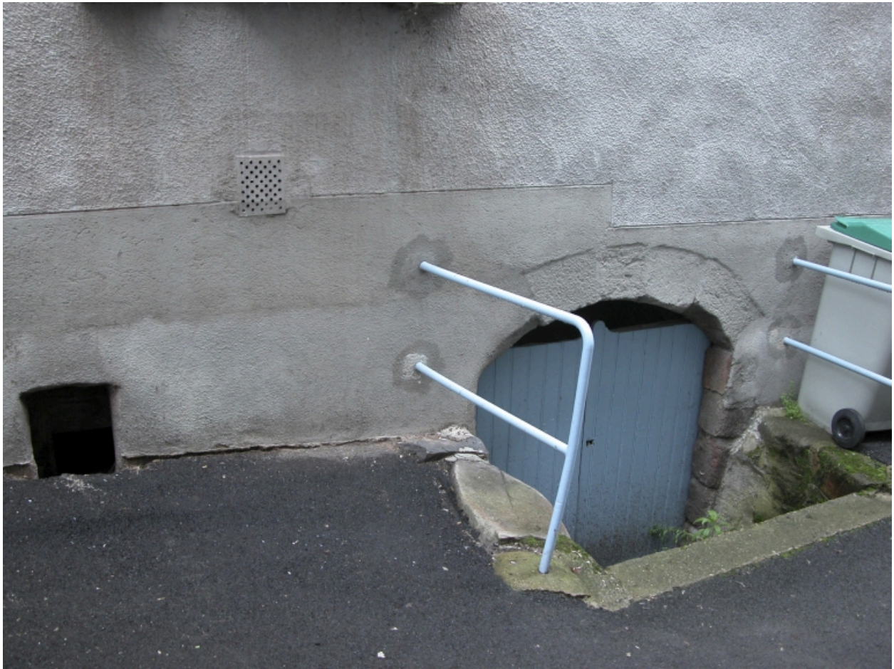
Îlot 2. Roanne (rue de) 05. Façade sur cour, détail du soubassement.
