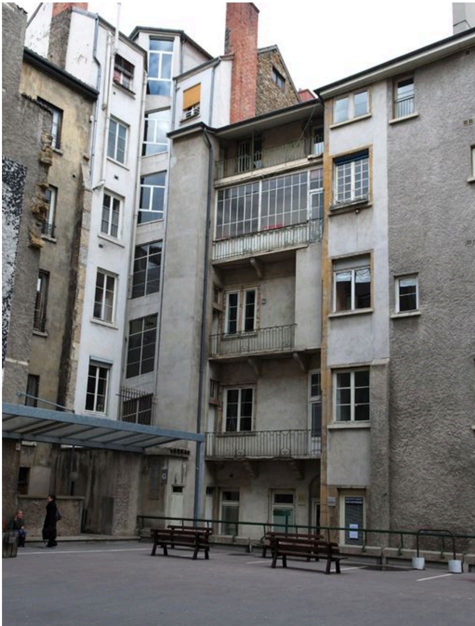
Elévation postérieure, vue de la partie occidentale
