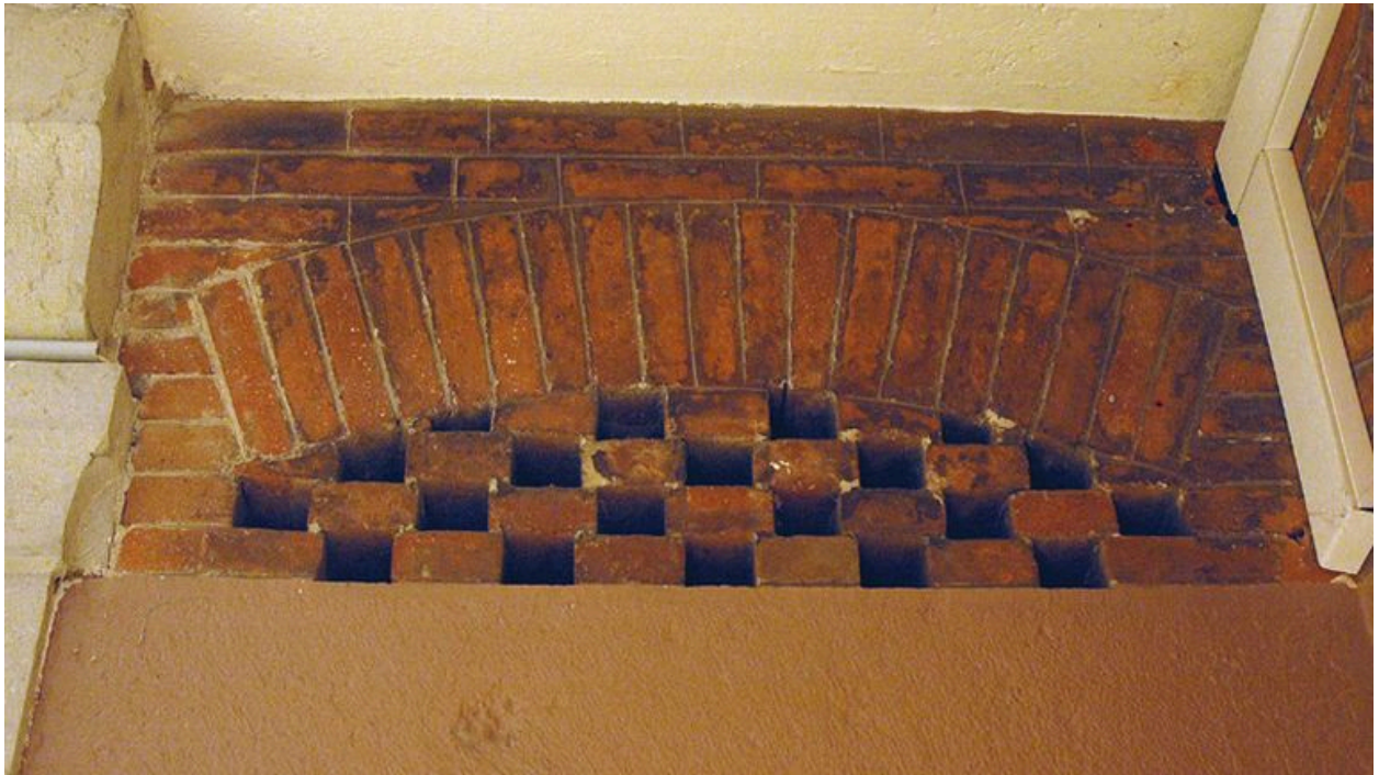
Porte latérale du vestibule de l'entrée principale, détail du claustra
