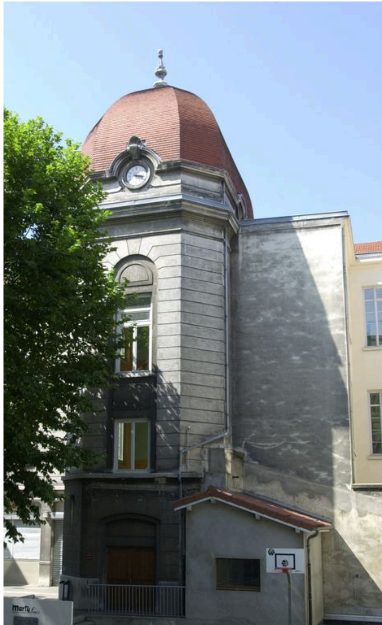
Vue de la façade du dôme dans la cour Grande rue de la Guillotière
