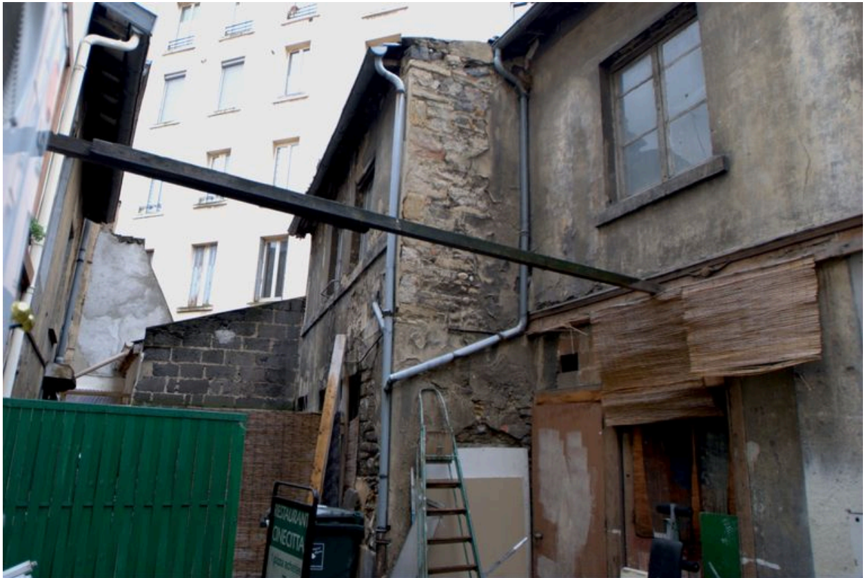
Vue d'ensemble de la cour commune depuis l'ouest
