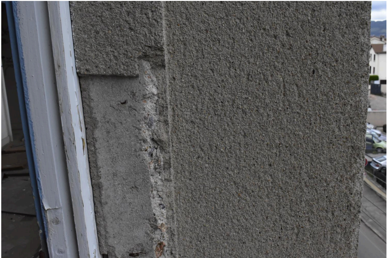
Détail du béton utilisé au niveau d'une baie du troisième niveau du bâtiment principal. [Photo chercheur.]
