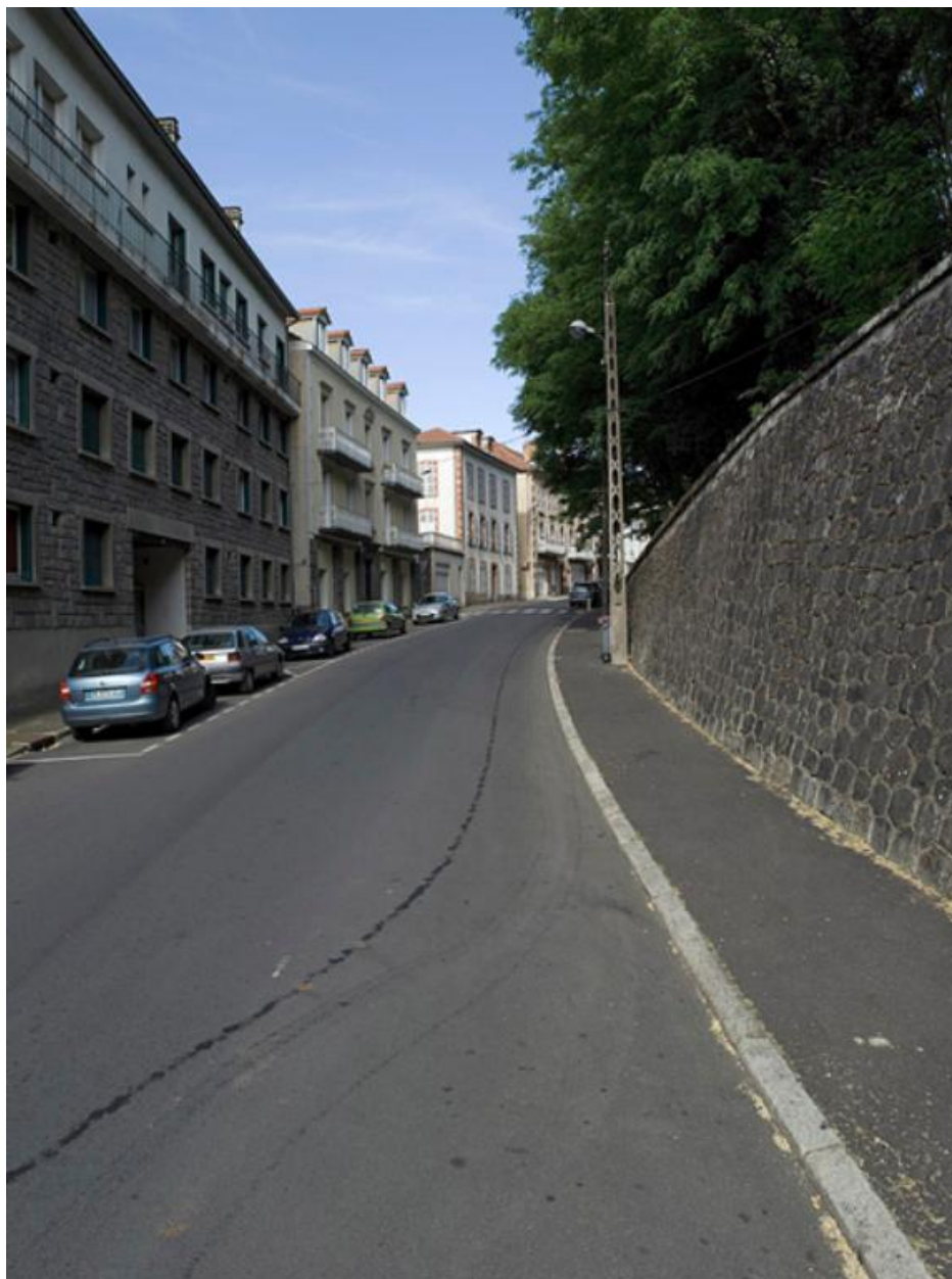
Partie basse de l'avenue en direction de l'ouest.
