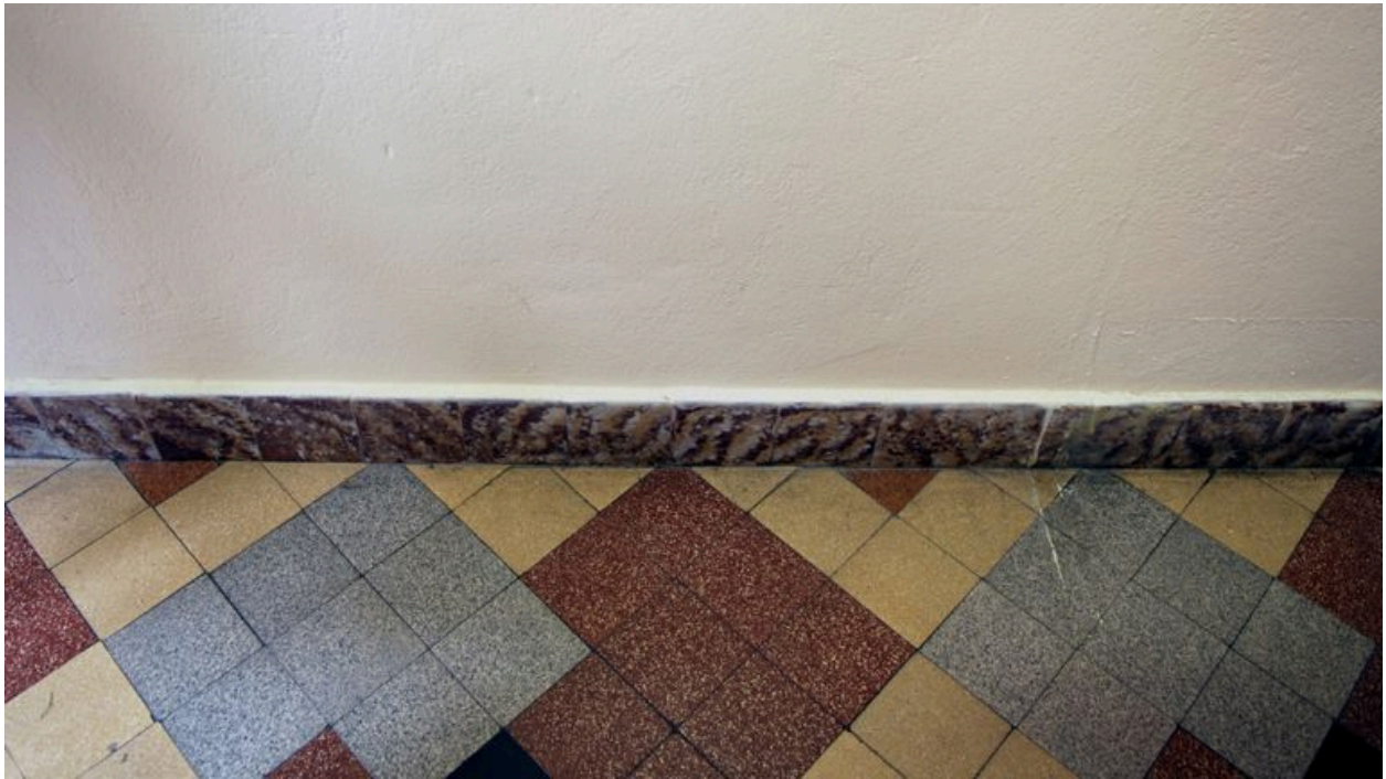
2e étage, couloir de l'aile sud, carrelage et plinthe
