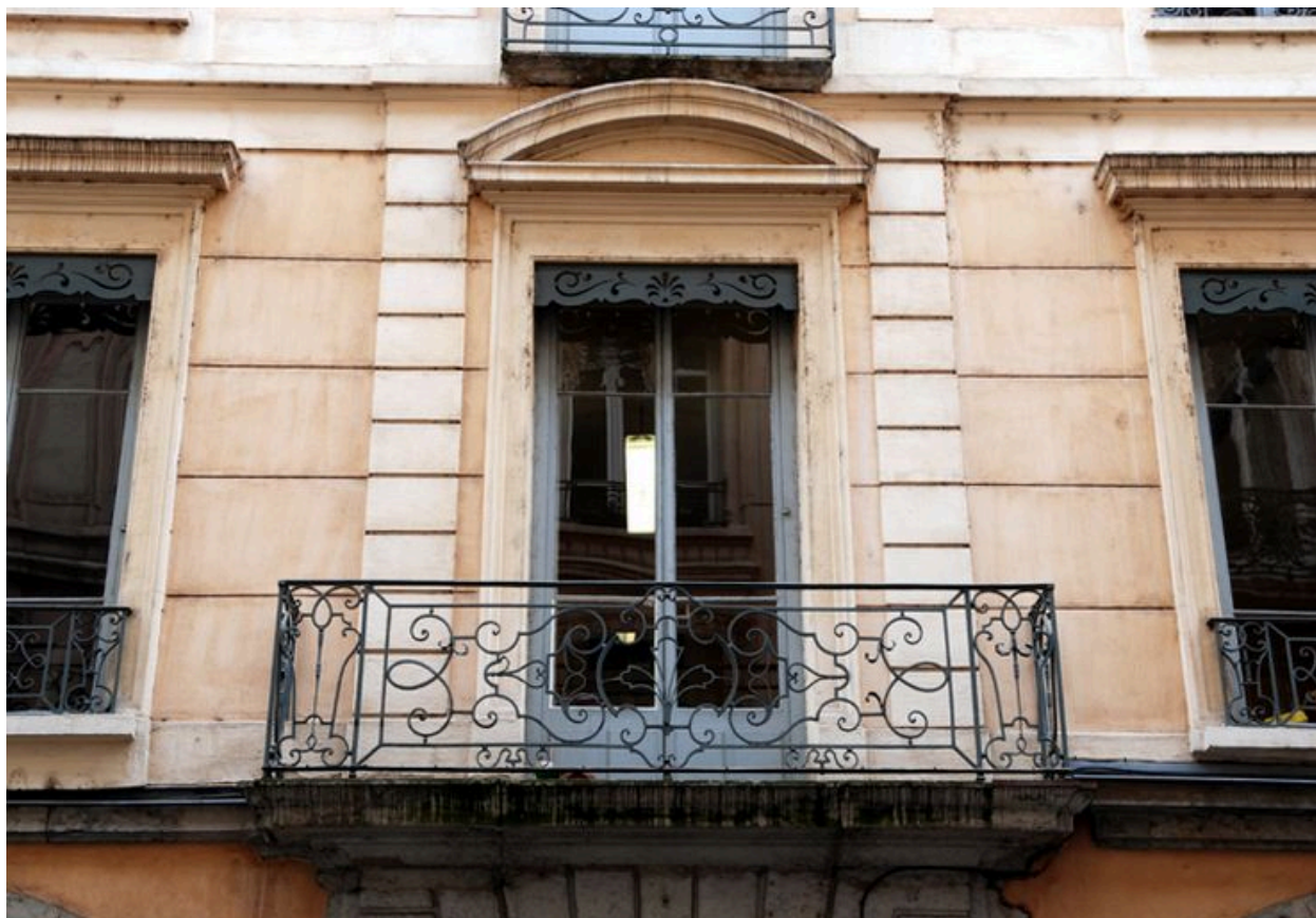
Elévation antérieure, baie centrale du premier étage
