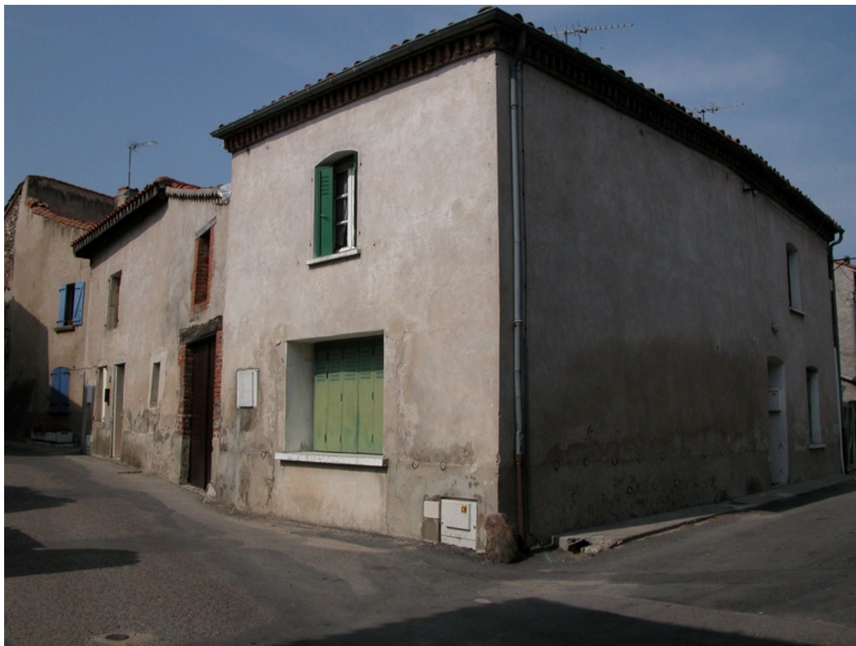
Le Bourg, rue du Château. Maison, cuvage (1999 AD 184).
