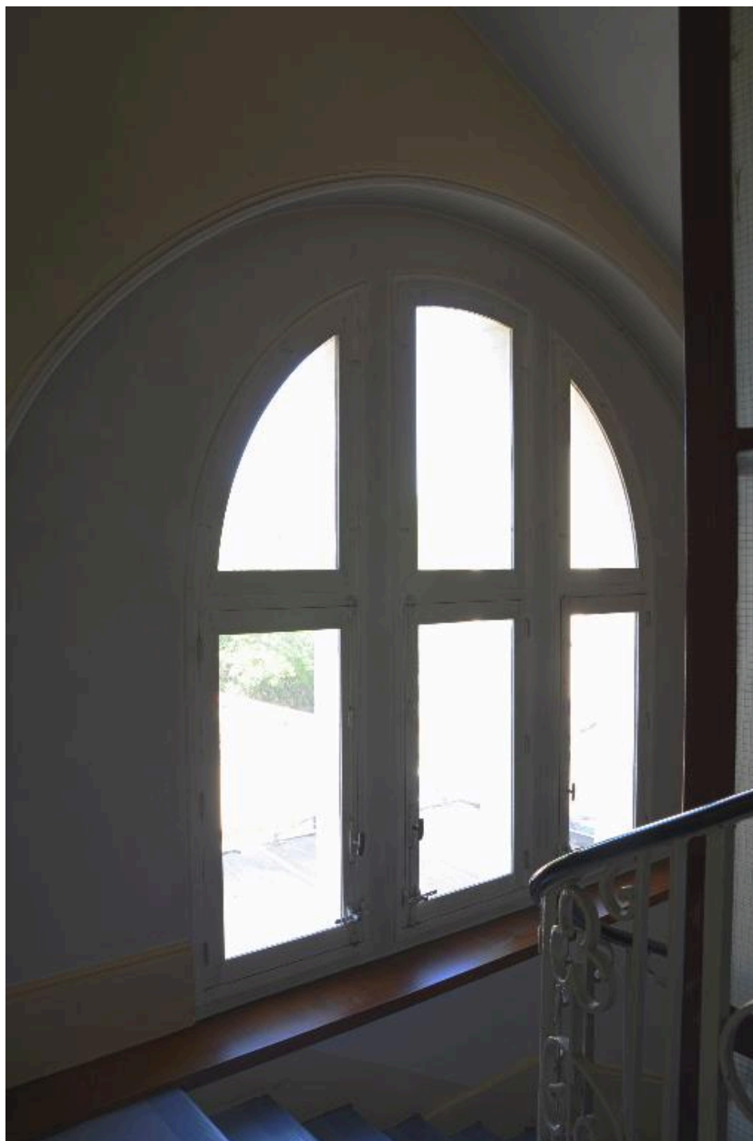
Baie éclairant la cage d'escalier
