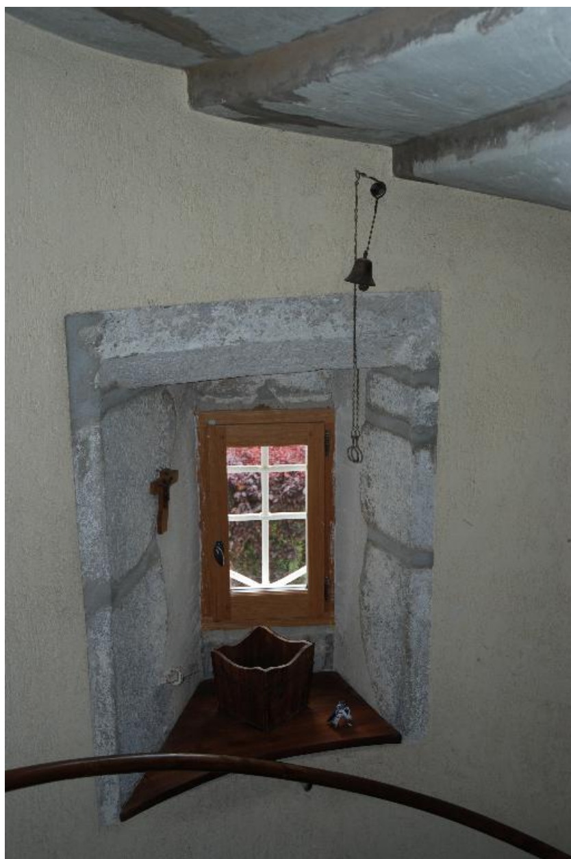
Escalier en vis. Fenêtre d'éclairage de la cage d'escalier.
