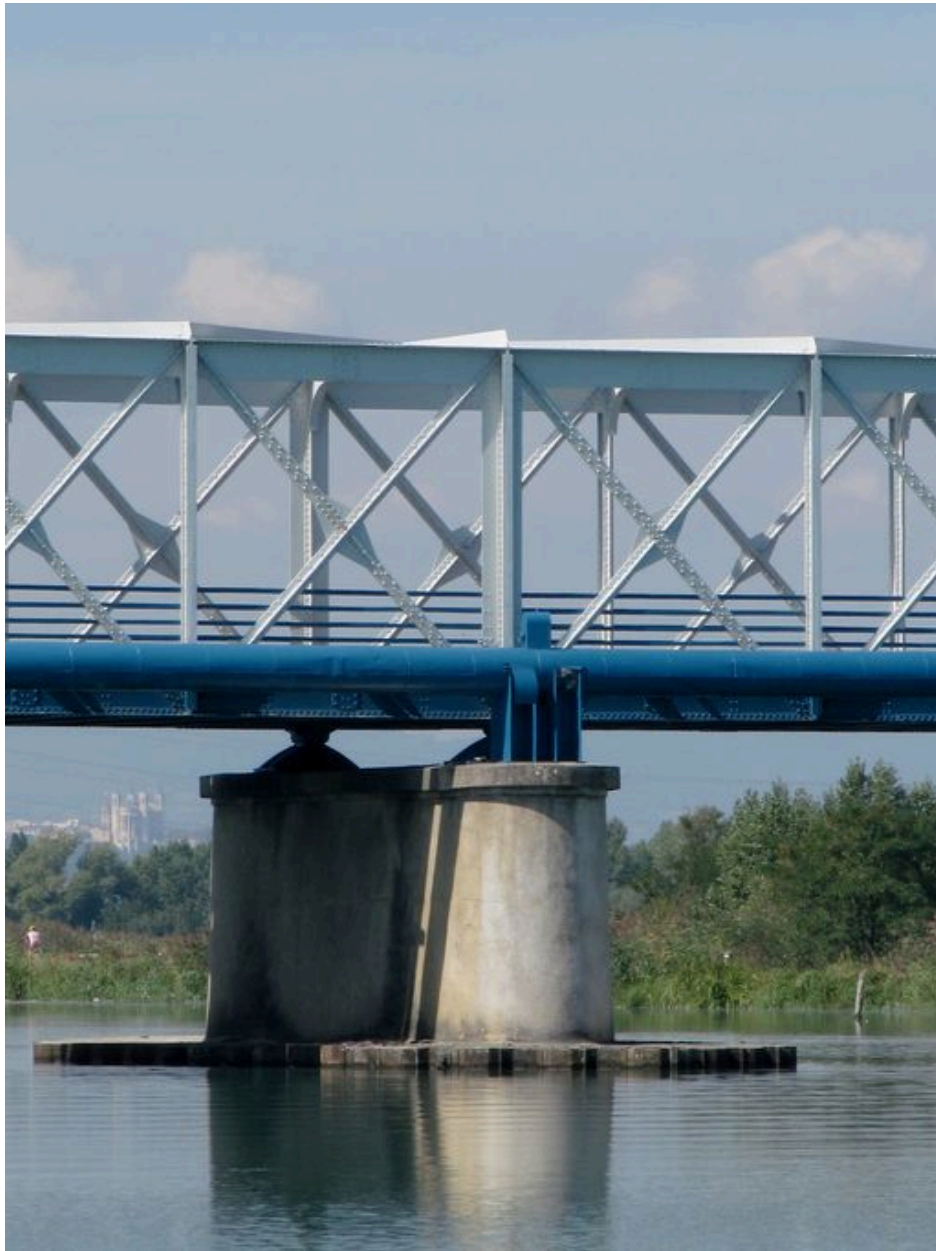
Pile, face amont, vue générale (depuis la rive gauche)
