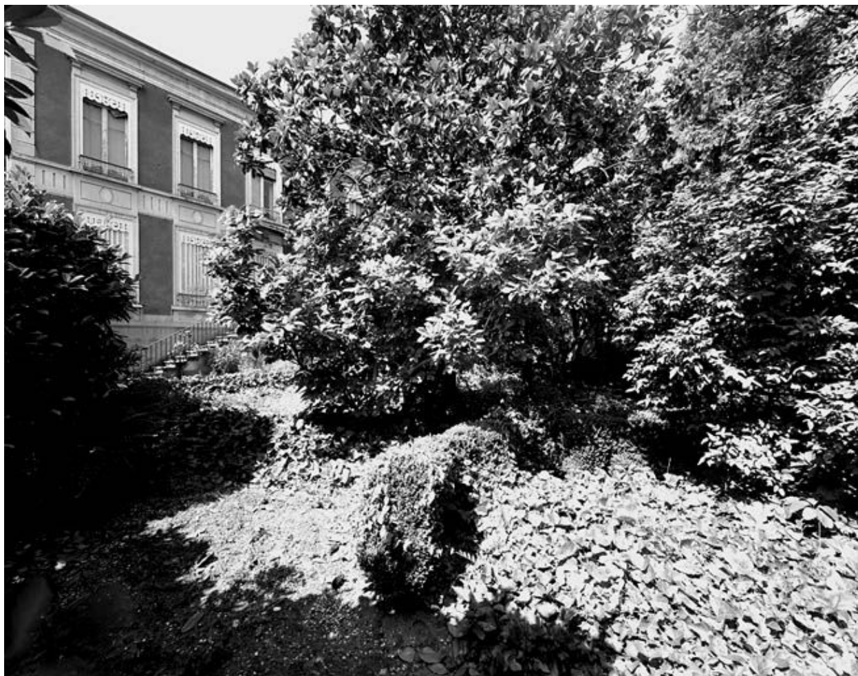
Elévation Est : vue partielle depuis le jardin
