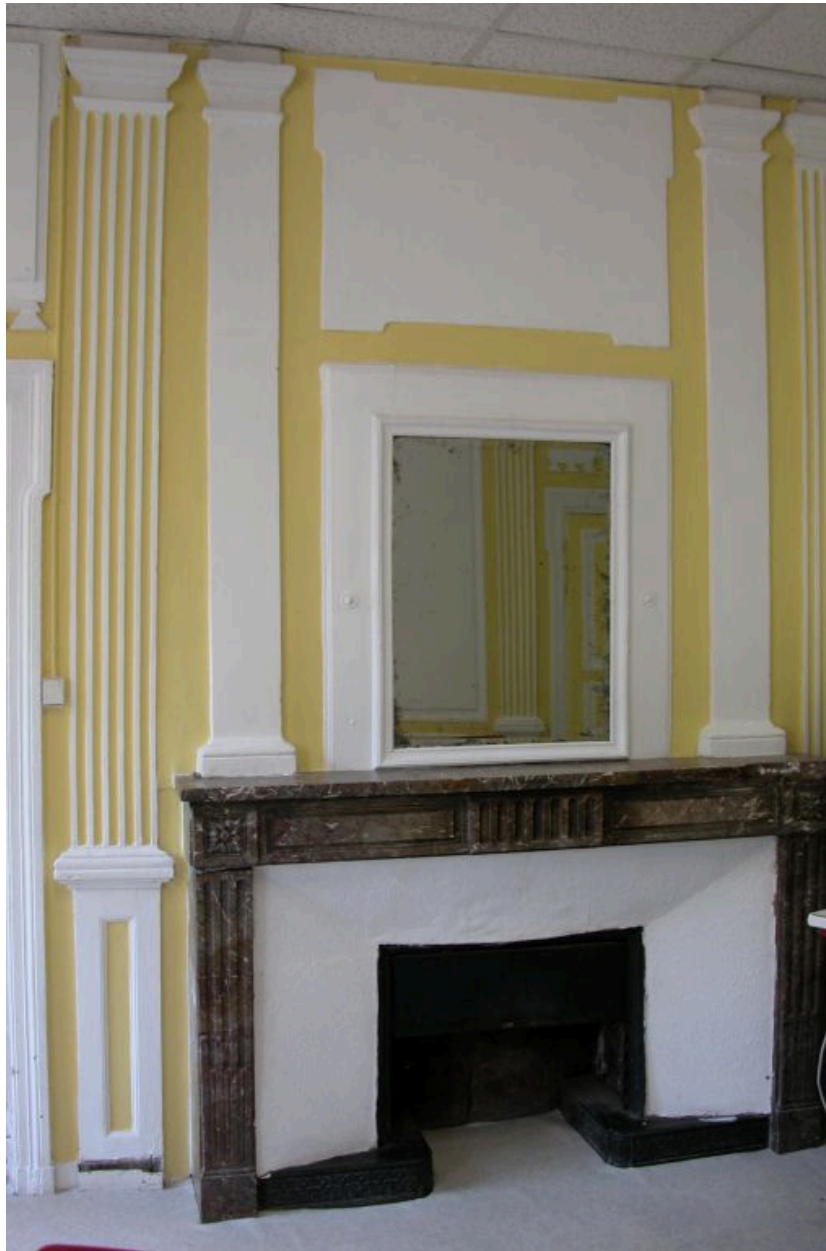
Cheminée engagée du salon au rez-de-chaussée, milieu 19e siècle.
