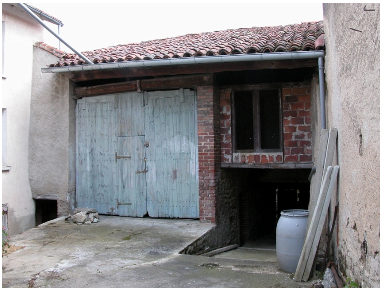
Vue d'ensemble de la grange-étable.
