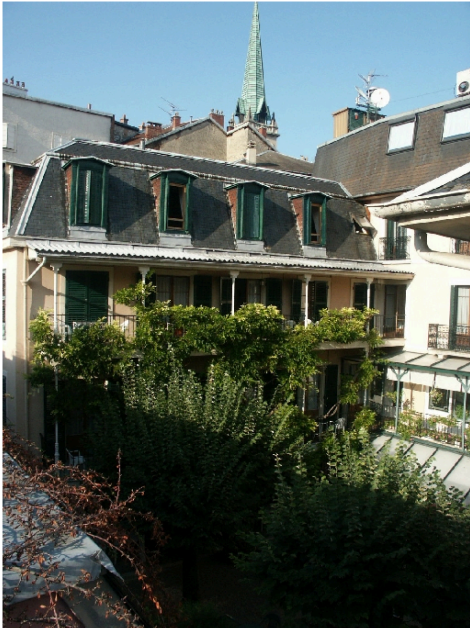
Elévation sur cour de l'aile nord
