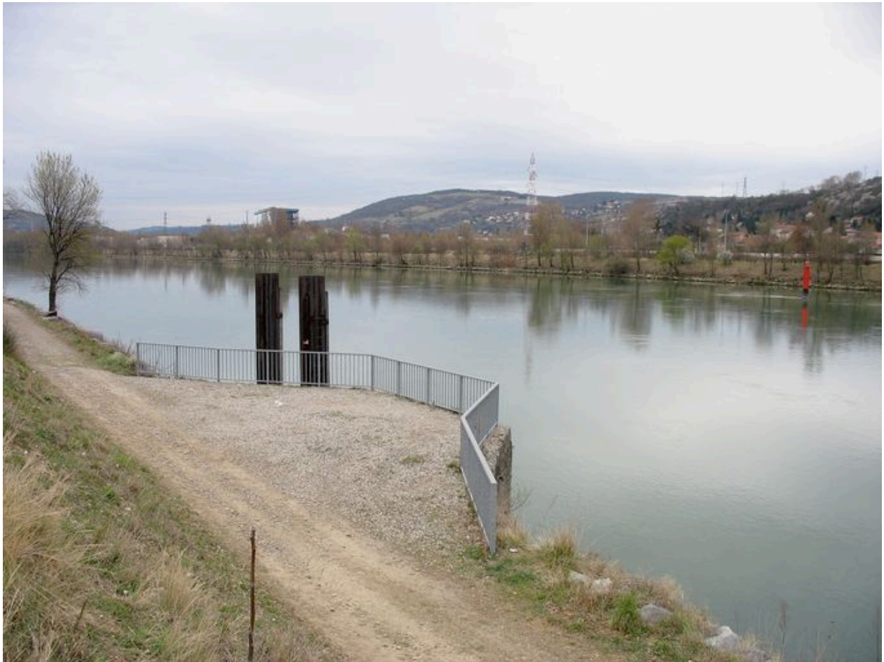
Vue générale de l'emplacement supposé du bac de la route de Bans
