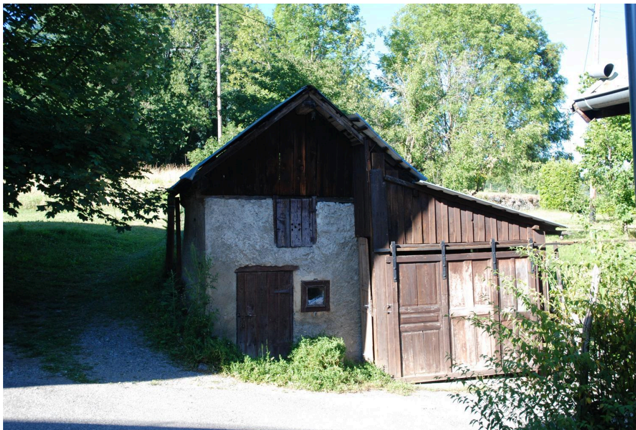
Fermes à bâtiments disjoints (2018 I1 57, 58, 1261), poulailler (2018 I1 40).
