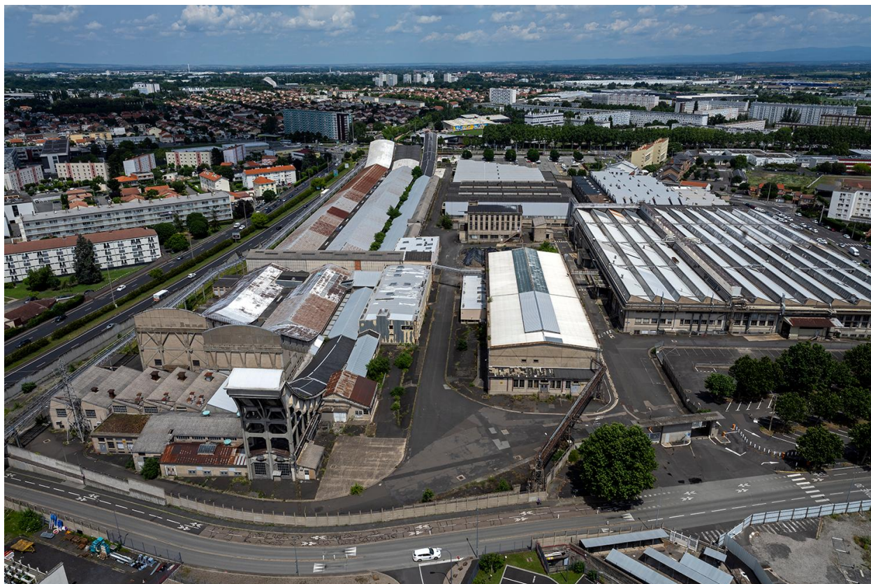
Vue aérienne de la partie nord-est du site, au-delà de la rue des Planchettes.
