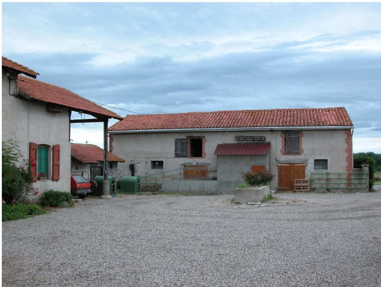
Vue du bâtiment est : étables.
