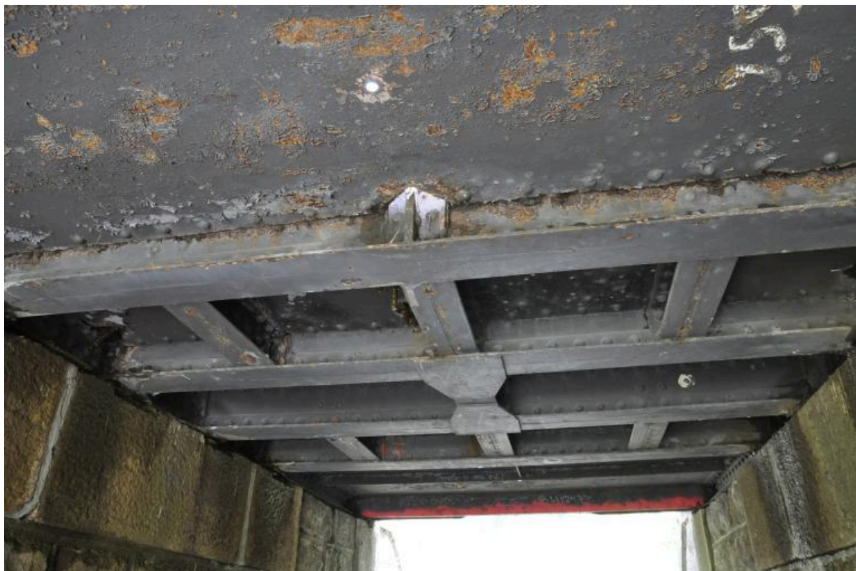
Détail du tablier du ponceau avec deux poutres jumelles sous rail
