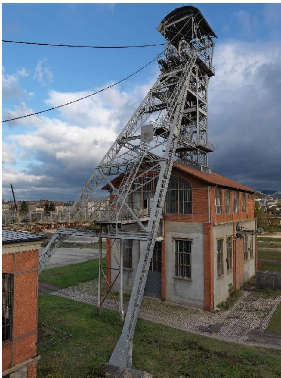
Vue ouest du chevalement
