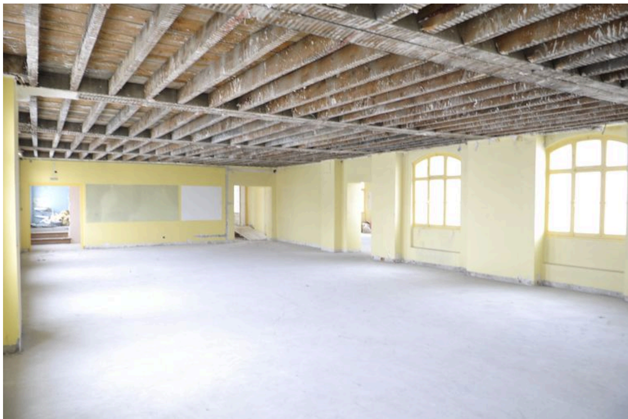
Vue du second niveau de l'étage des dortoirs, entresolé en 1932.
