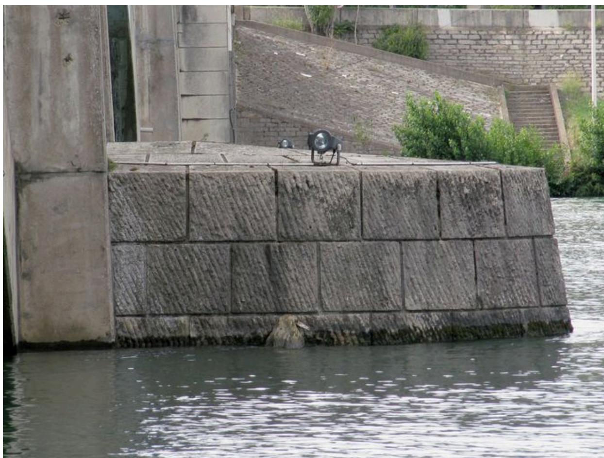
Pile, face amont, vue de détail : avant-bec (depuis la rive gauche)
