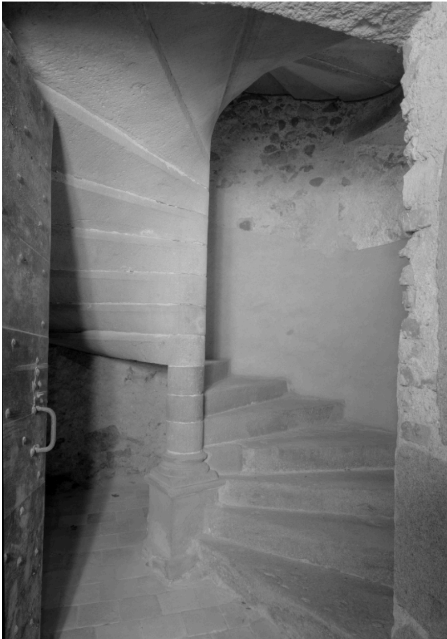
Bastion ouest, rez-de-chaussée : vue du départ de l'escalier en vis.
