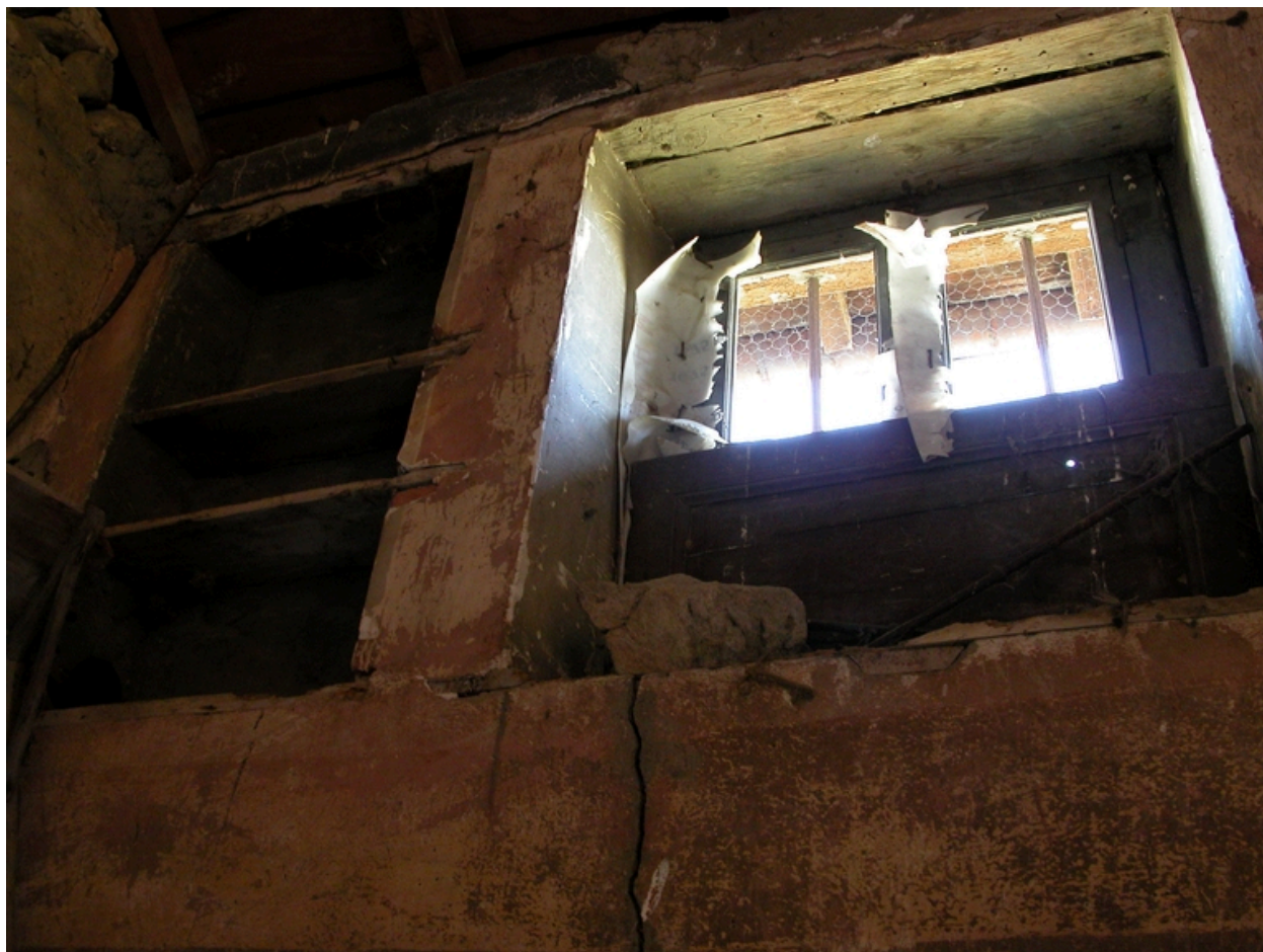
Vue intérieure de l'étage : détail du placard et de la fenêtre.
