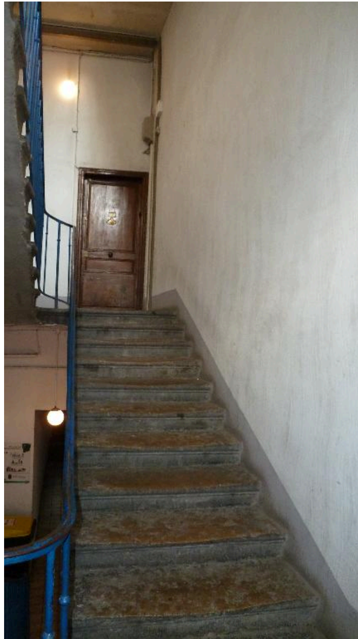
Vue de l'escalier depuis le repos
