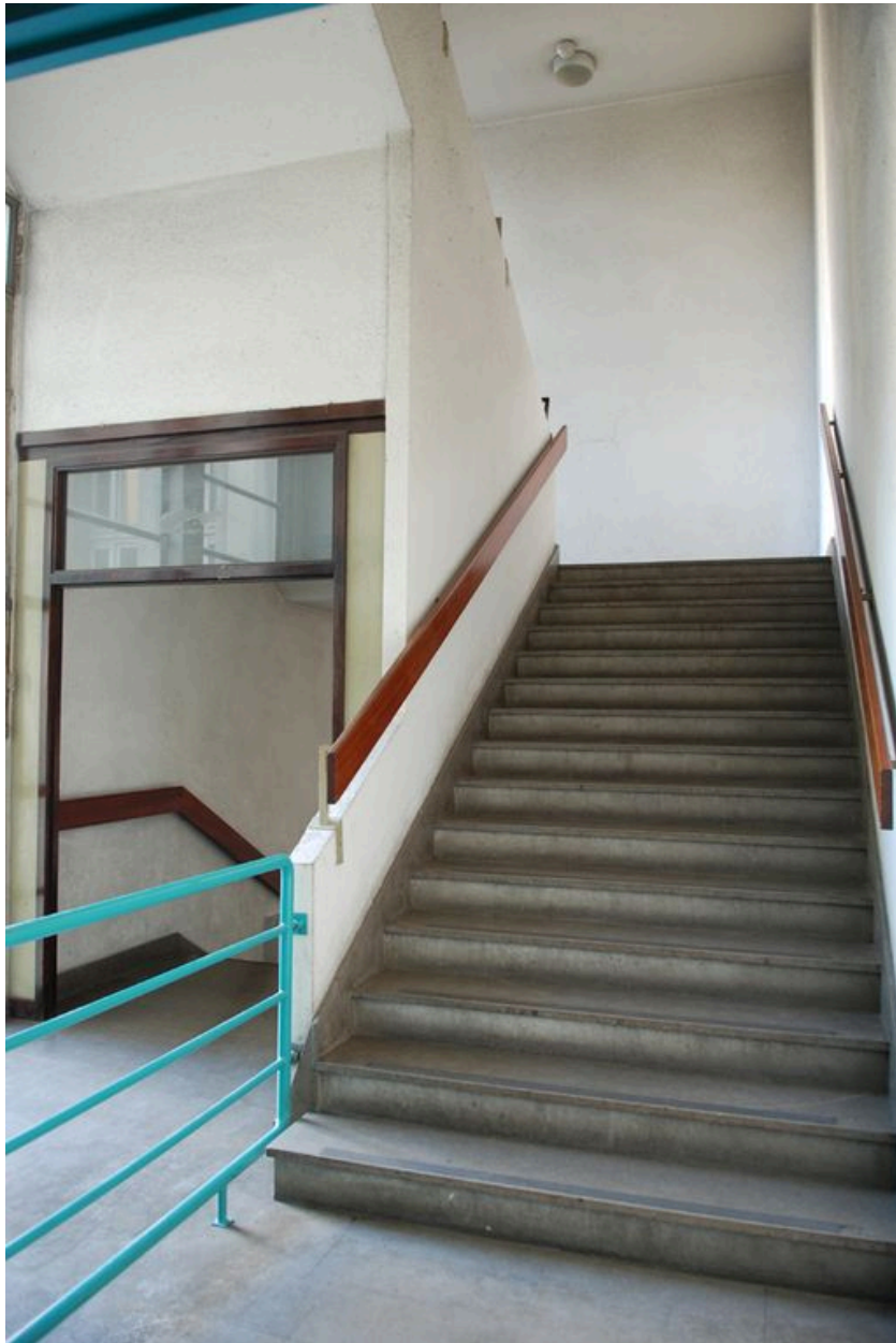
Bâtiment ISARA (2nd tranche), escalier, palier du rez-de-chaussée
