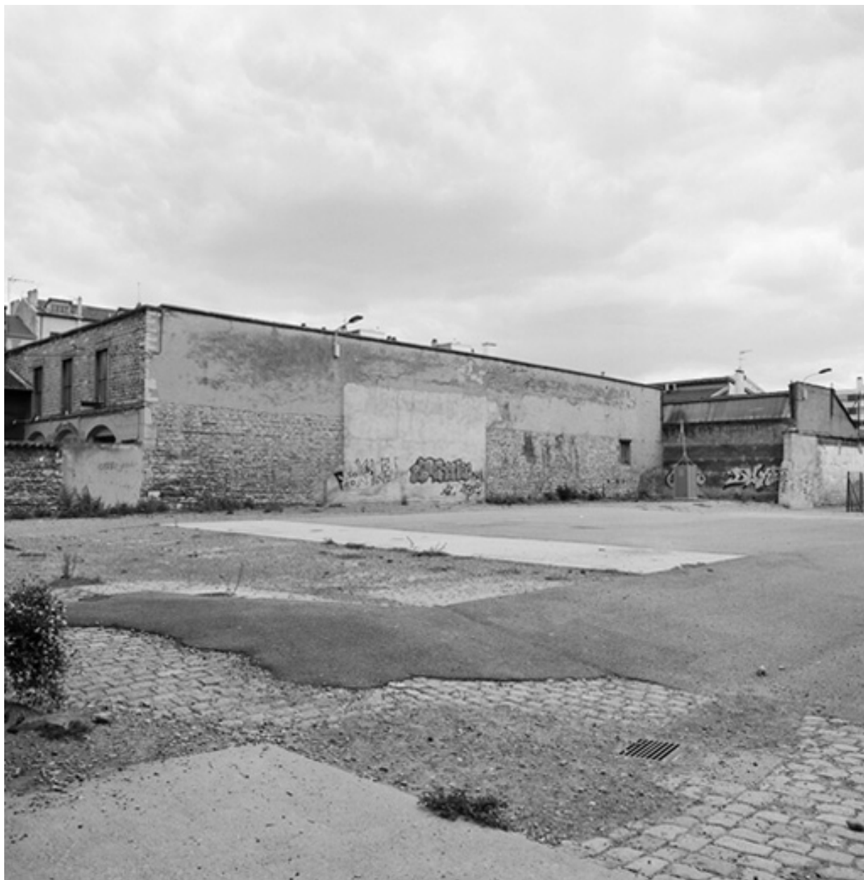
Façade nord ouest
