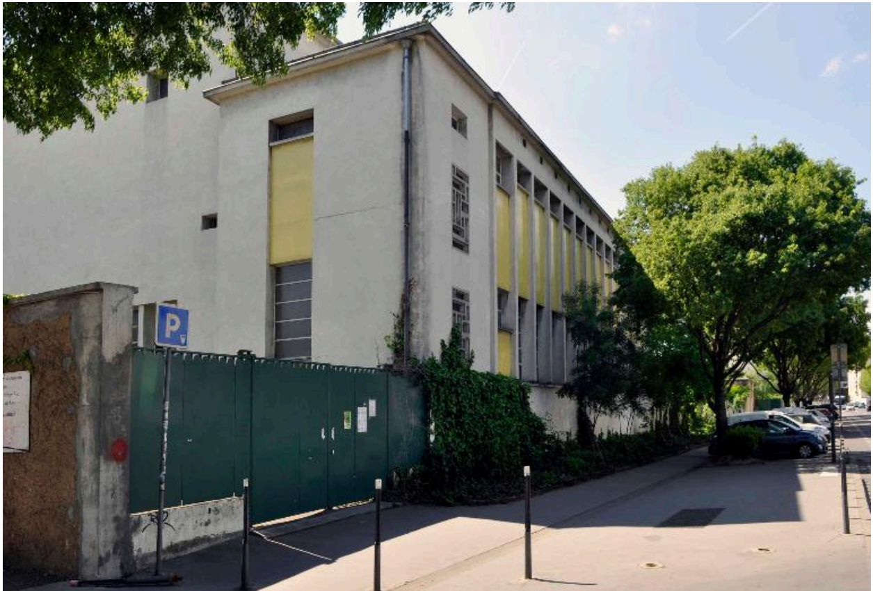
Gymnase, élévation postérieure depuis l'est
